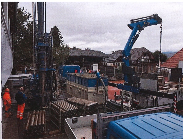
(Bohrarbeiten unt. Schulhaus)
